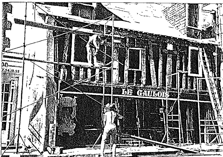
Place Cabello, restauration d'une maison à pans de bois ; à remarquer l'emplacement des anciennes fenêtres.
