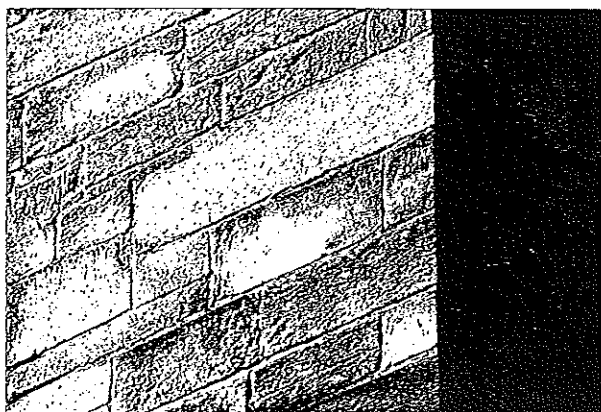
Rue Noé, château Gaillard, appareil réglé en granit à joints minces.
